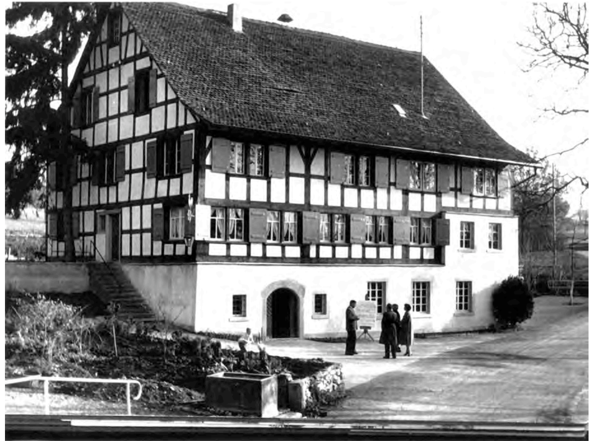
Kittenmühle Herrliberg, Renovation 1956-1958
